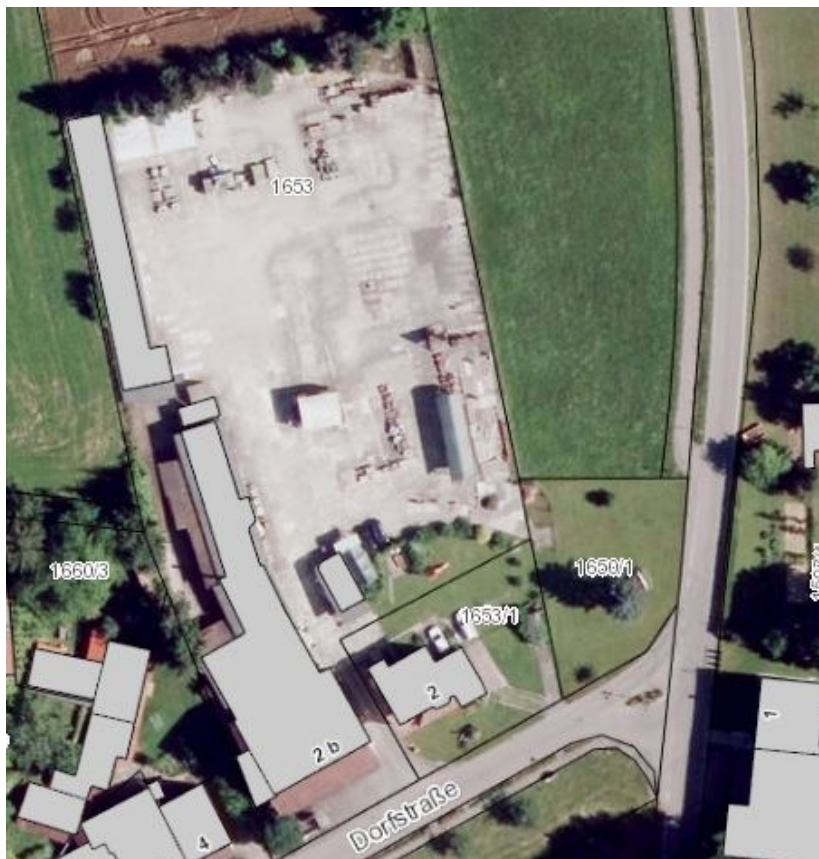
Abb. 1: Die Abrissgebäude der Dorfstraße 2 bzw. 2b des ehemaligen Baustoffhandels. (Quelle: LUBW; nicht maßstäblich)
