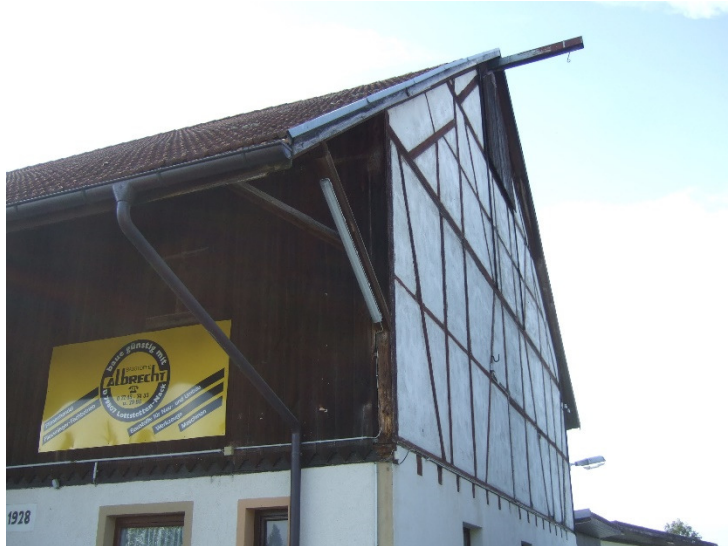
Abb. 2: Abrissgebäude der Dorfstraße 2b des ehemaligen Baustoffhandels. Zwergfledermausquartier hinter der der gelben Werbetafel (Spaltenquartier zwischen Tafel und Holzverschalung)
