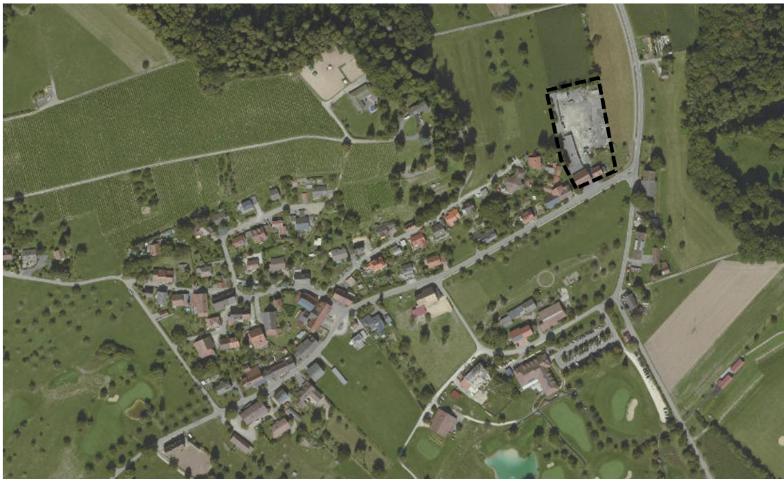
Luftbildausschnitt des Ortsteils Nack mit schematischer Darstellung des Plangebiets (Quelle: LUBW, ohne Maßstab)
