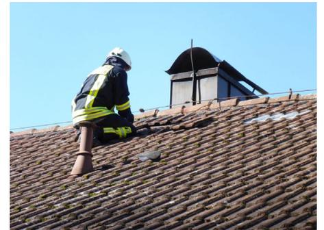
Mit einem Spiegel konnten glühende Glanzrußnester im oberen Teil des Kamins lokalisiert und mit Spezialwerkzeug und Steinen nach unten beseitigt werden. Unter Anwesenheit des Bezirksschornsteinfegermeisters wurden laufende Temperaturmessungen mit der Wärmebildkamera durchgeführt. Dabei wurden Temperaturen bis zu 450°C gemessen. Zur Sicherung des Brandschutzes wurde das 1. Rohr in Stellung gebracht.
